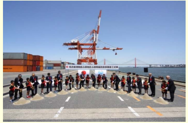
6/4 名古屋港飛島ふ頭地区ふ頭再編改良事業着工式典 来賓者、関係者による鍬入れ式 (名古屋港湾事務所)
