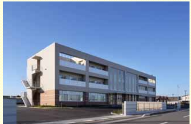
4 / 18 三重県警察機動隊新庁舎の外観(北東面)
