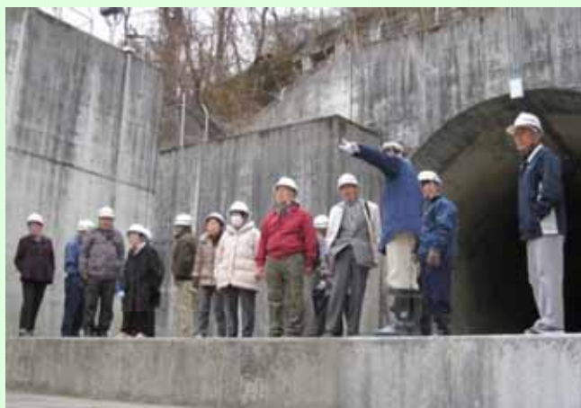
3 / 23 美和ダム土砂バイパストンネルを見学 土砂バイパストンネルの吐口を見学する地元の方たち
