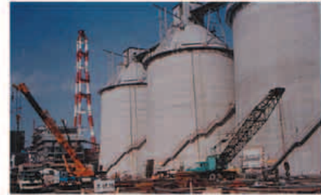
図 四国電力西条発電所の石炭サイロ (1983-2-9 藤村撮影)
