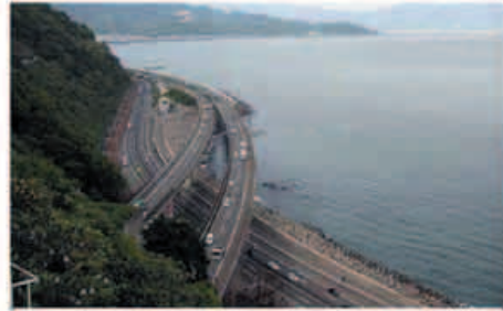
写真 由比の東海道新幹線・東名高速道路・国道の交錯地点 (2005-5-20畑村撮影)
