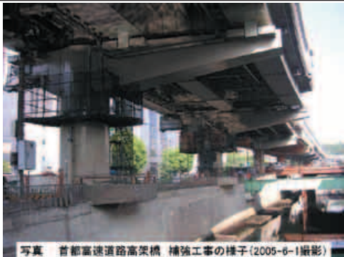
写真 首都高速道路高架橋 補強工事の様子 (2005-6-1撮影)
