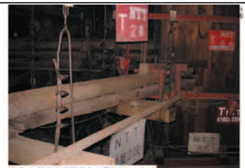
写真 首都高速道路中央環状線トンネル 工事現場② (2005-7-13畑村撮影)
