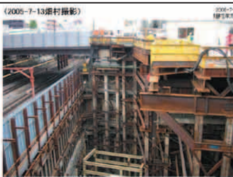
写真 首都高速道路中央環状線トンネル 工事現場③
