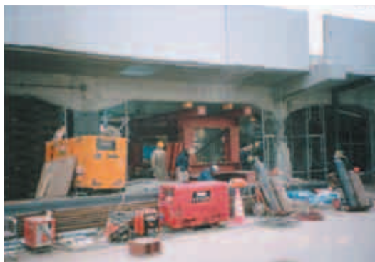
写真 阪神大震災で壊れた山陽線橋脚の鉄板巻きコンクリートによる補強 (1995年2月9日畑村撮影)
