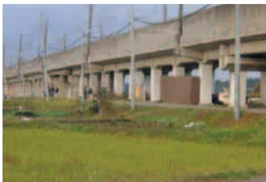
写真 鉄板巻きコンクリートで予め補強してあった高架橋の橋脚
