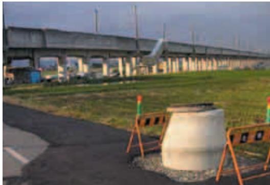
写真 地盤の液状化で浮き上がったマンホール
