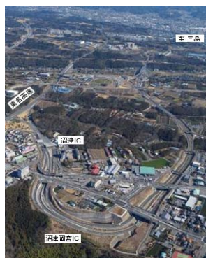
東駿河湾環状道路 沼津岡宮IC付近
