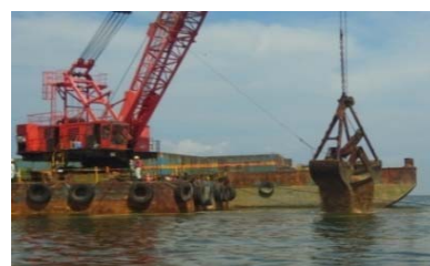
造成材の投入・均し状況 (田原市伊川津町地先) 【出典】愛知県
