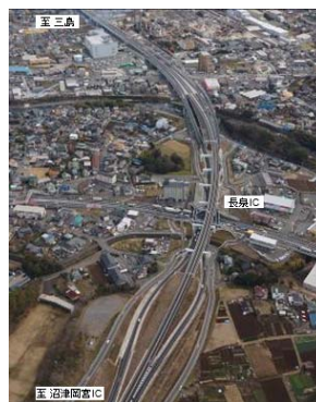
東駿河湾環状道路 長泉IC付近
