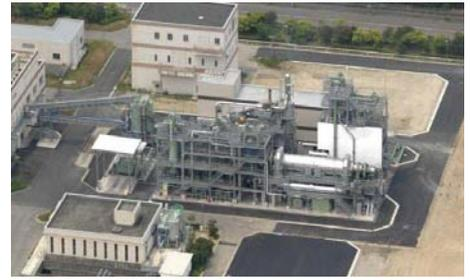
下水汚泥燃料化施設(右手前キルンが炭化炉)
