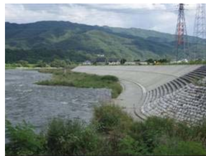
事業後 写真提供：中部地方整備局
