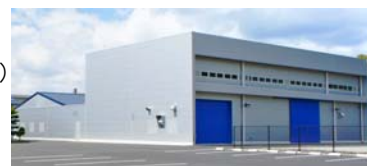
ぎふ技術革新センター 写真提供:岐阜県
