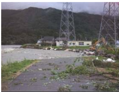
事業前 写真提供：中部地方整備局
