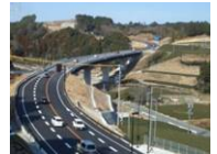
相良バイパス 東萩間ICより北を望む 写真提供：静岡県
