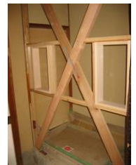
筋交による耐震補強 写真提供：三重県
