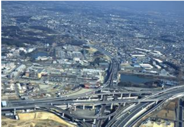
名古屋南JCTから北東を望む 写真提供：NEXCO中日本
