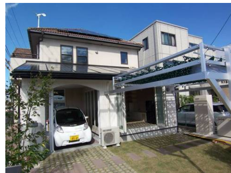
独立型エネルギーインフラ「GREENY岐阜」 (岐阜市内:住宅モデル) 平成22年11月公開 写真提供:岐阜県
