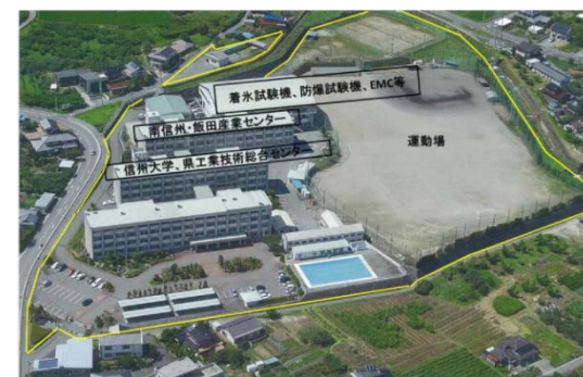
航空機システム拠点(旧飯田工業高校)
