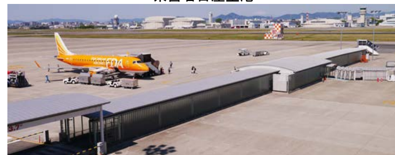
屋根付き搭乗通路「フィンガーコンコース」
