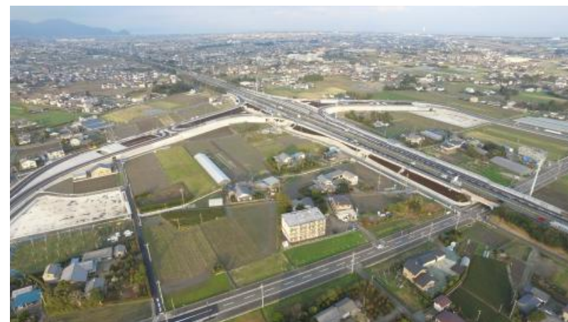
完成写真(全景)
