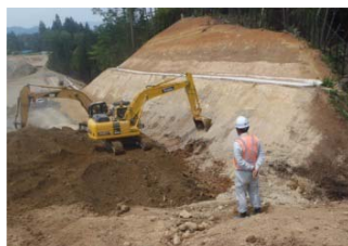
法面整形の施工状況
