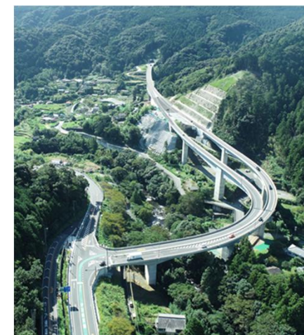
伊豆縦貫自動車道 【中部地方整備局】
