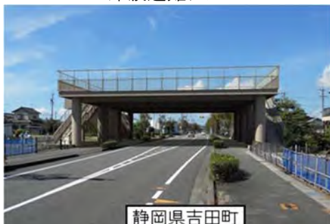
津波避難タワー
