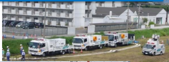
排水オペレーション(三重県長島町)
