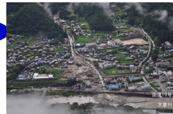
平成26年南木曾町梨子沢土石流(土砂被害)
