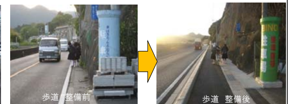
一般国道42号 鶴殿歩道整備(三重県紀宝町)
