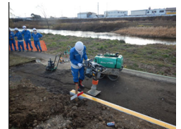
■路盤の締固め
