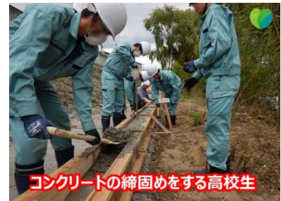
■ 高校生によるコンクリート締固め体験
