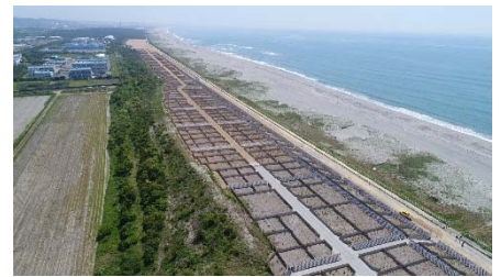
■“ふじのくに”のフロンティアを拓く取組「静岡モデル防潮堤整備（袋井市）」
