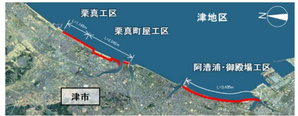
■津松阪港海岸 堤防改良対象工区
