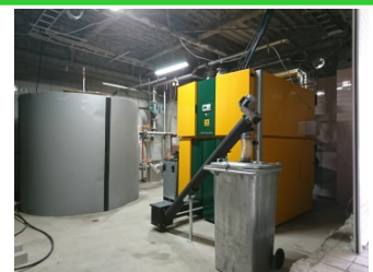
■温浴施設に設置した木質バイオマスボイラー
