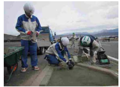
■高校生によるブロック敷設の状況
