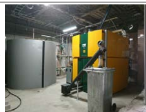
■ 温浴施設に設置した 木質バイオマスボイラー
