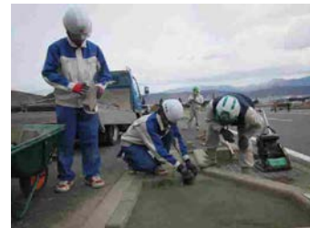
■高校生によるブロック敷設の状況
