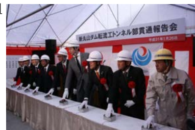
■新丸山ダム転流工トンネル部貫通報告会(貫通発破の様子)
