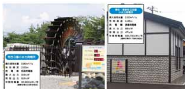
（小水力発電所の整備）
