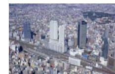
名古屋駅周辺 出典：中部地方整備局資料
