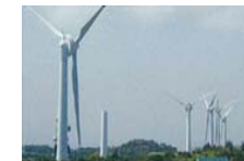
青山高原ウインドファーム (風力発電施設) 提供:青山高原ウインドファーム
