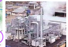
森の発電所 (木質バイオマス発電) 出典:中部経済産業局HP
