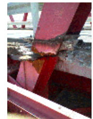
木曾川大橋 鋼材破断
