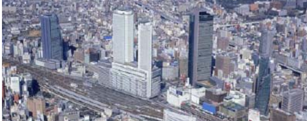
提供: 中部地方整備局
