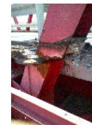
木曾川大橋 鋼材破断
