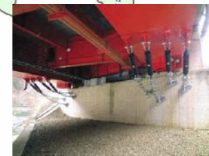
耐震補強（落橋防止） 出典：中部地方整備局資料
