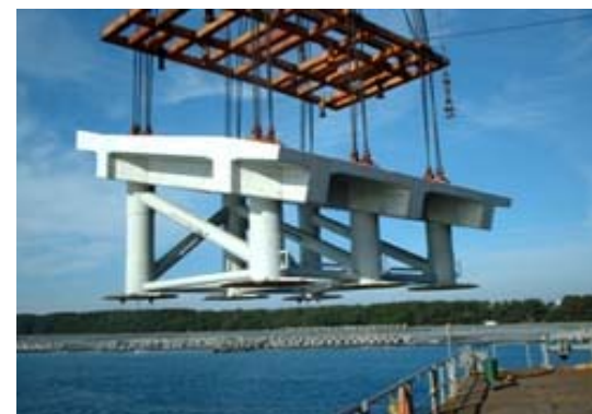
有脚式離岸堤(駿河湾)
