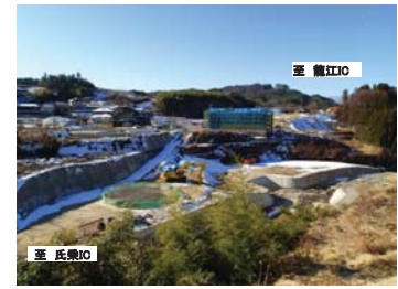
<三遠南信道 飯橋道路 飯田東IC（仮称）付近 工事状況>
