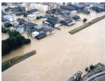
東海豪雨水害(H12.9)
