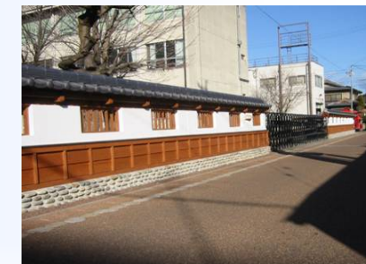
門扉の修景(愛知県犬山市)
