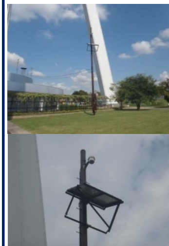
アンテナの設置状況
