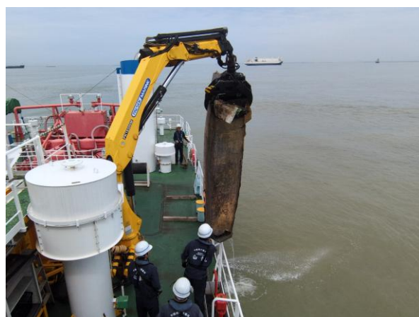
クレーンで朽ちた木造船（約7m）を回収 （9月12日）
