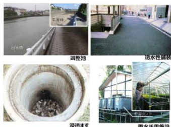
雨水貯留浸透施設の例
