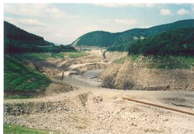
阿木川ダムの状況
