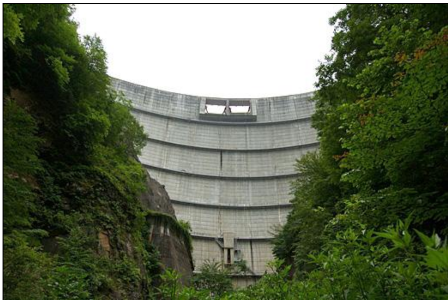
高根第1ダム(中部電力(株))
