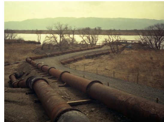
仮設配管の設置 （平成7年度渇水時の事例）
