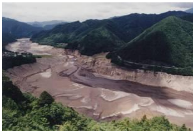
牧尾ダムの状況
