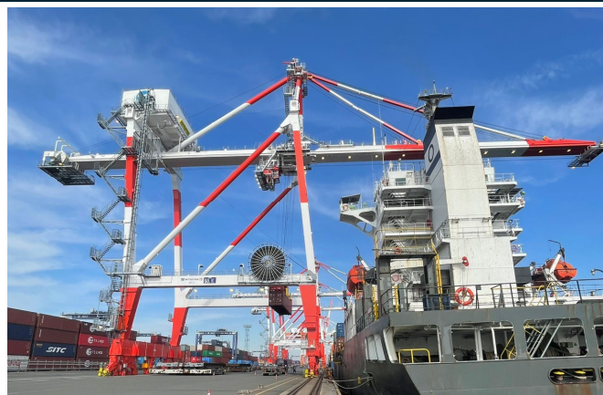
インバーター制御方式のガントリークレーンの導入 (供用開始した新1号機)
