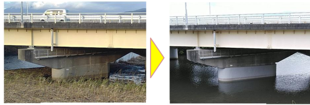
【対策事例】橋梁の耐震対策（橋脚補強）
