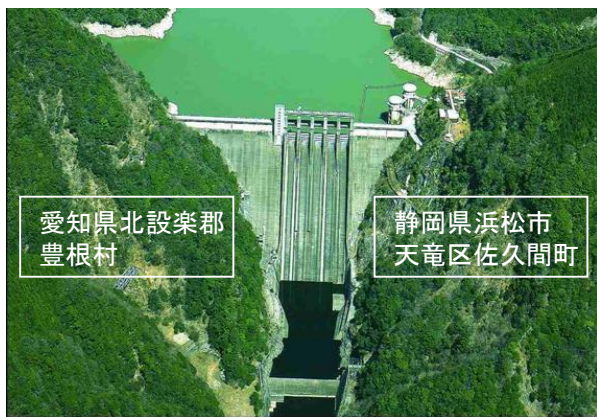
佐久間ダム(電源開発(株)S31完成)
