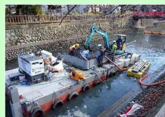
河床掘削の実施 (水門川:岐阜県)
