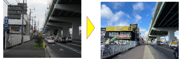
【整備事例】無電柱化（電線共同溝）
