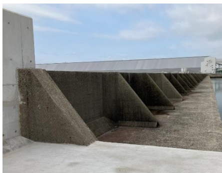
上部工の嵩上げ（整備前）
