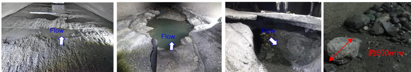
令和2年7月梅雨前線による出水時のトンネルインバート摩耗状況
