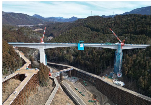
付替県道瀬戸設楽線(5号橋)
