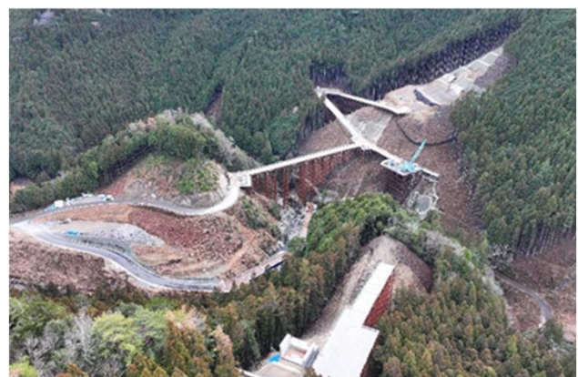
付替県道瀬戸設楽線(3号橋)
