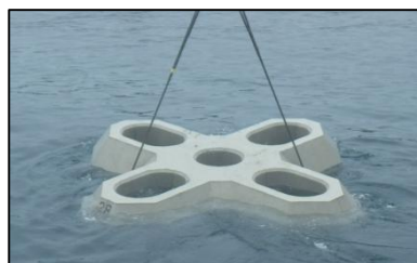
基礎の流出防止対策 (被覆ブロック据付)
