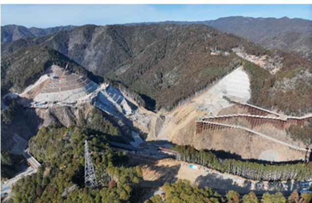
本体工事(基礎掘削)
