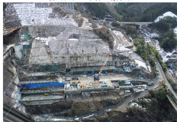
左岸減勢工 コンクリート打設状況
