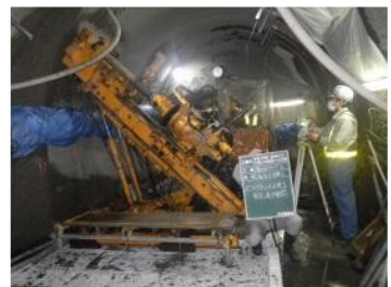
集水ポーリング工
