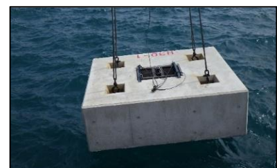
越流による洗掘防止対策 (根固方塊据付)
