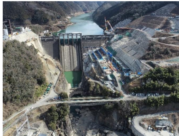
新丸山ダム本体全景状況
