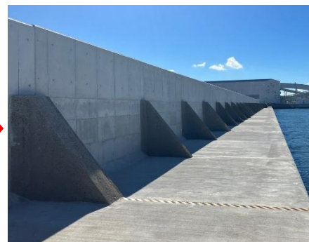
上部工の嵩上げ（整備後）
