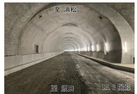
さんえんなんしん 三遠南信自動車道 あおくずれとうげ 青崩峠道路 本坑
