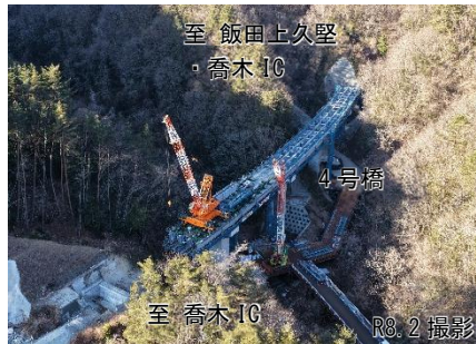
さんえんなんしん 三遠南信自動車道 いいたか 飯喬道路 4号橋付近
