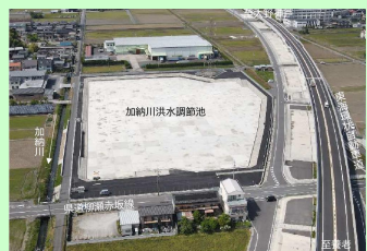
洪水調整池の整備 (加納川洪水調整池:岐阜県)
