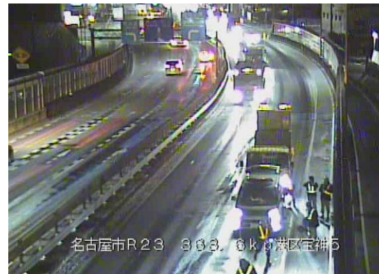
国道23号庄内新川橋（渡河部の橋梁）
