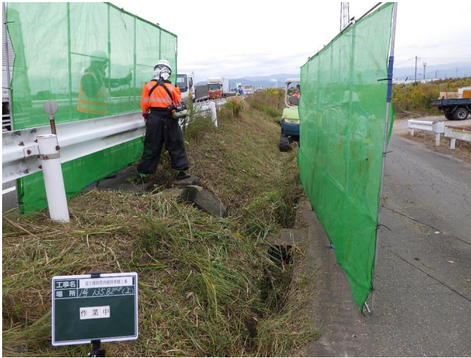
強風や大型車両通過による風圧で飛び石防止フェンスが煽られ、転倒などにより、事故発生に繋がる恐れがあり作業の継続が困難
