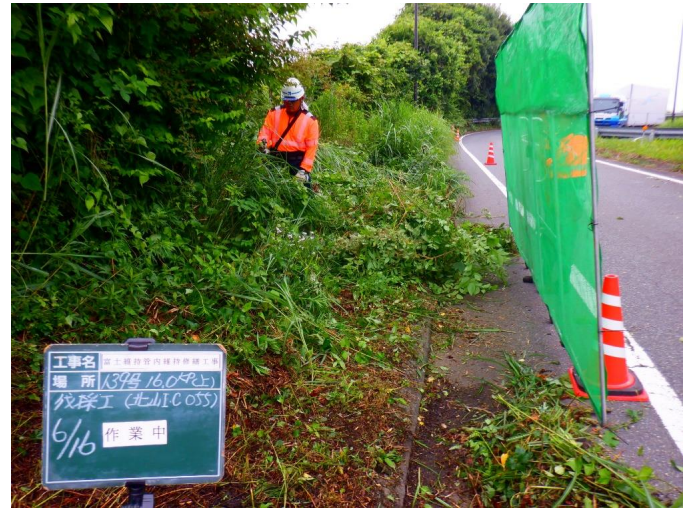
強風や大型車両通過による風圧で飛び石防止フェンスが煽られ、転倒などにより、事故発生に繋がる恐れがあり作業の継続が困難
