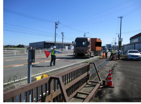
三重河川国道事務所（誘導状況）
