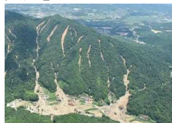
同時多発的な表層崩壊や土石流
