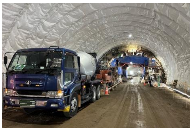
トンネルの覆工工事の様子をご覧ください！
