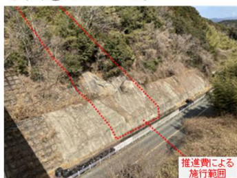
写真① 法面全景
