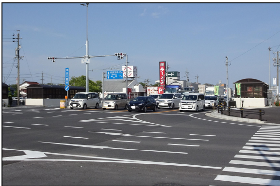
が ま 国道 2 1 号河間交差点（岐阜県 大垣市）
