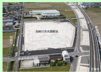
洪水調節池の整備 (加納川洪水調整池:岐阜県)
