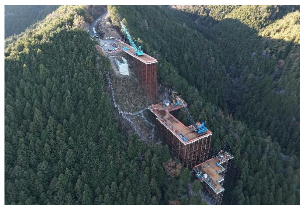
付替道路418号(7号橋)
