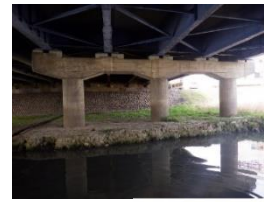
【対策事例】橋梁の耐震補強
