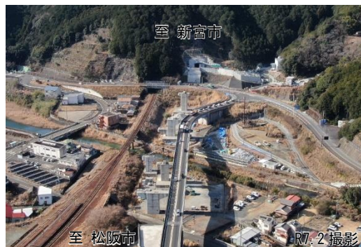
熊野道路 熊野大泊IC付近
