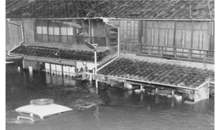
写真1:軒下まで浸水した家屋
