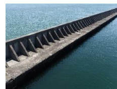
【対策事例】防波堤上部の改修
