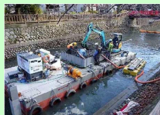
河床掘削の実施 (水門川:岐阜県)
