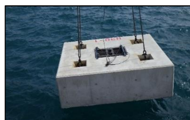
越流による洗掘防止対策 (根固方塊据付)
