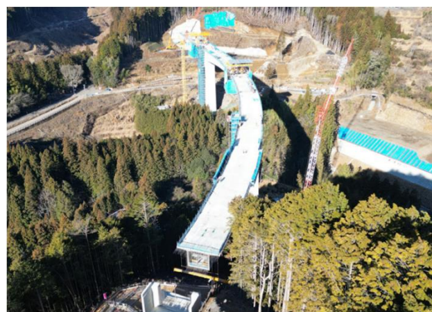
付替国道257号線(4号橋)
