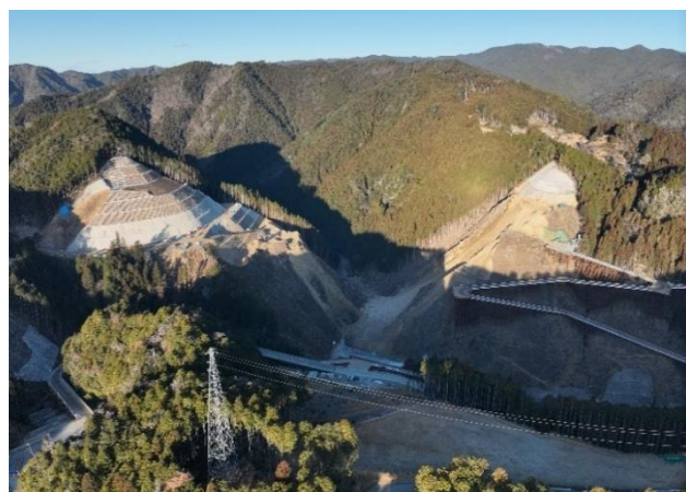
本体工事(基礎掘削)
