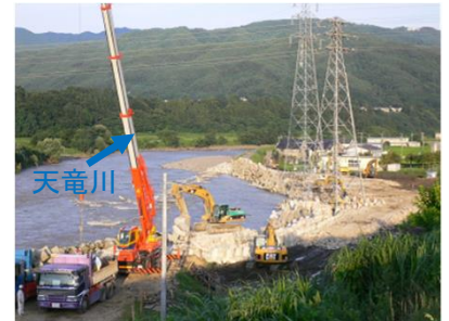
平成18年7月豪雨応急復旧状況
