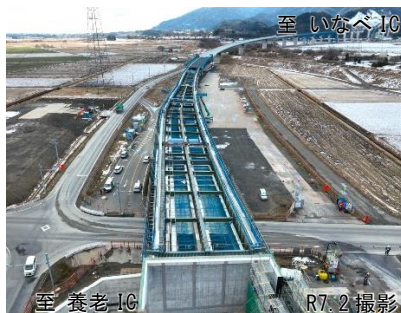
東海環状自動車道 海津PA 付近
