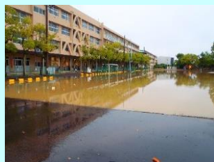
校庭貯留の実施 (北小学校:大垣市)
