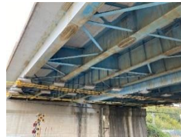
【対策事例】橋梁の再塗装
