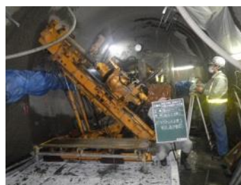
集水ボーリング工
