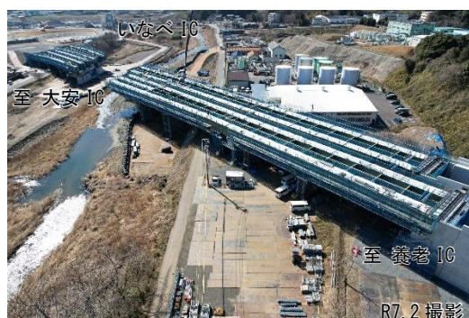
東海環状自動車道 いなべIC付近
