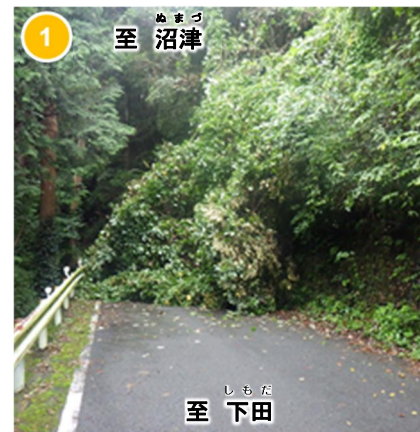
■台風、大雨等による伊豆南部の被災状況
