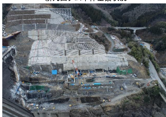
左岸減勢工 コンクリート打設状況
