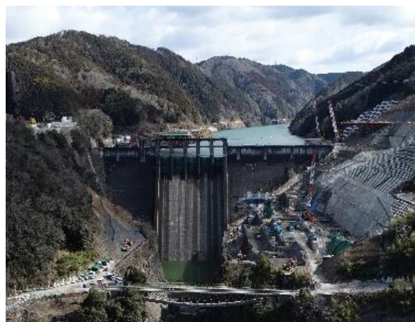
新丸山ダム本体全景状況
