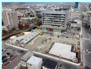
雨水調節池の整備 (大垣市役所新庁舎:大垣市)
