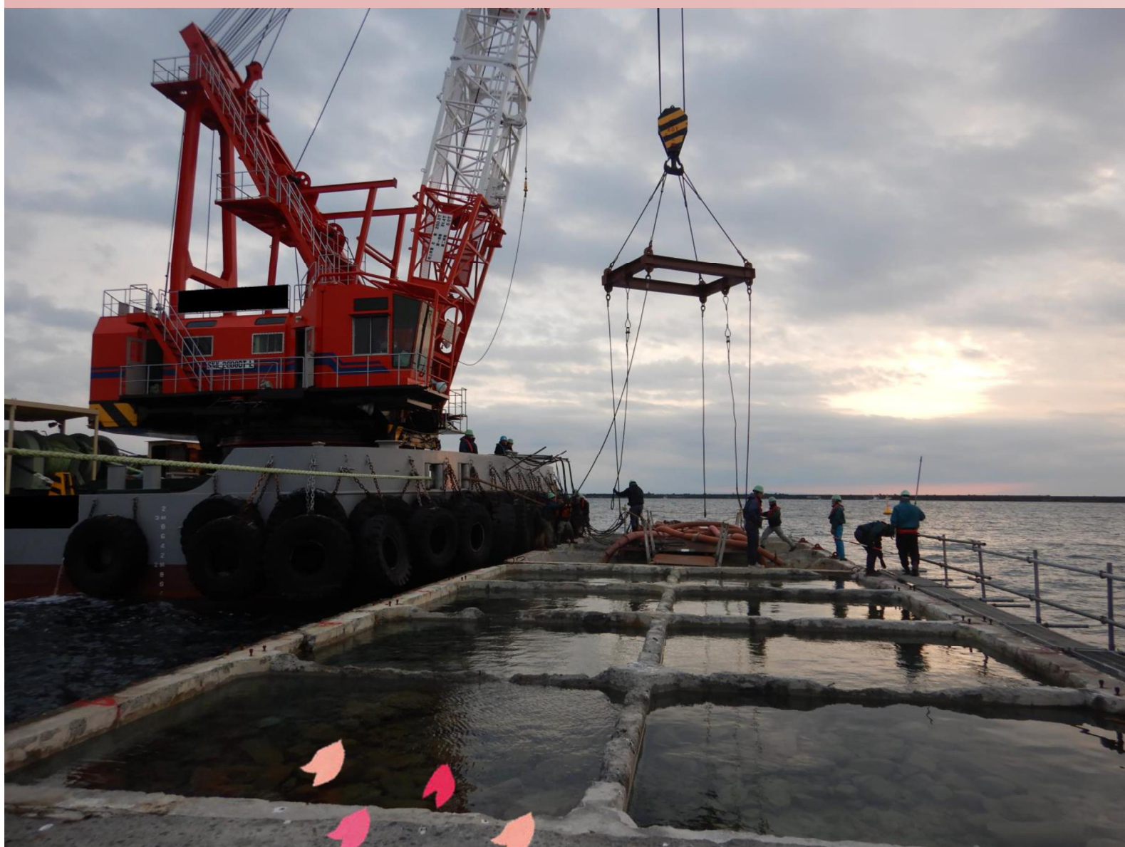
御前崎港 既設岸壁改良 (静岡県)
