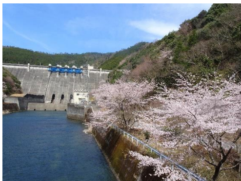
河川 28 蓮ダム (三重県)
