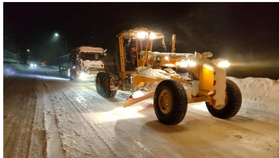
(令和6年2月 国道17号 群馬県みなかみ町)
