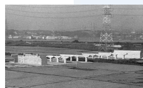
知立バイパス 今川高架橋 施工状況[S52]
