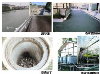
雨水貯留浸透施設の例
