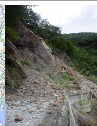
＜土砂崩落状況＞ 9月21日(土)8:00 (静岡市HP)
