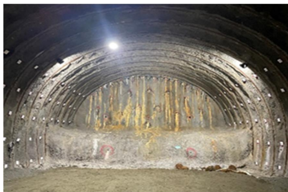
普段は入ることのできないトンネル内部を確認できます！
