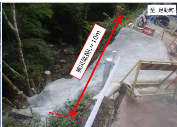
写真② 応急対策後
