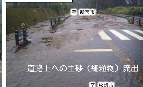
写真②被災状況
