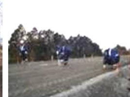
検測と施工を繰り返して整形
