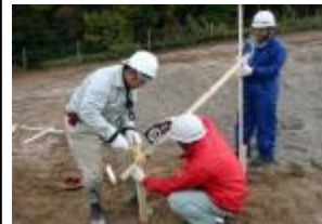
設計図に合わせて丁張り設置
