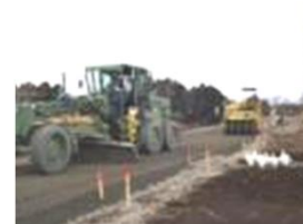
丁張りに合わせて施工
