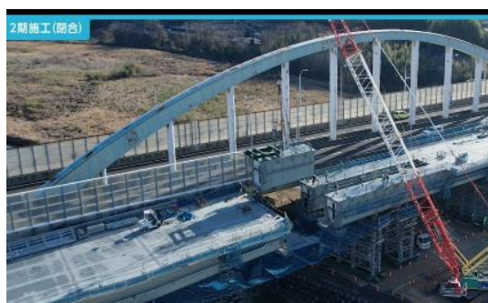
庄内川大橋タイムラプス動画も見学
