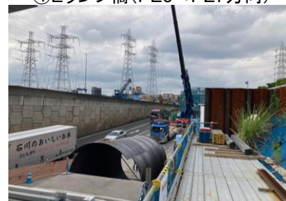
④Eランプ橋(PE6→PE7方向)
