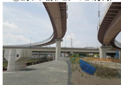
③Eランプ橋(PE3→PE4方向)
